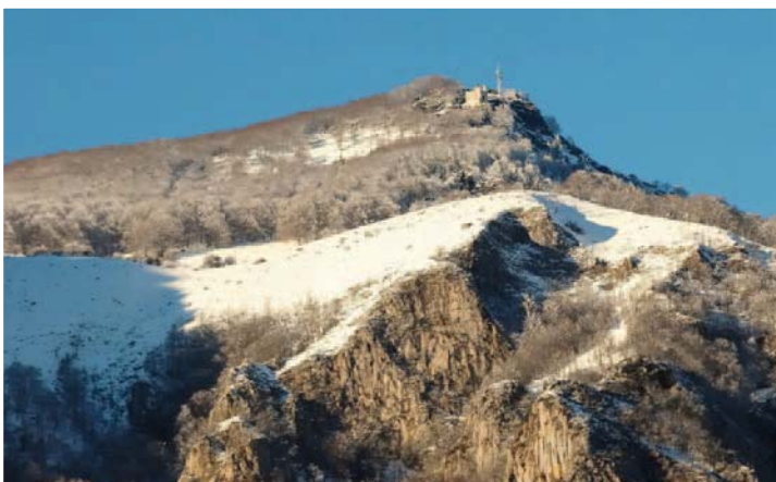
Bâtiment sommital Pibeste
