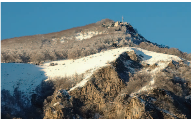
Bâtiment sommital Pibeste
