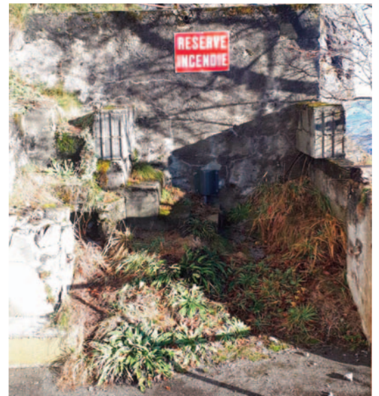
Bâtiment sommital Pibeste
