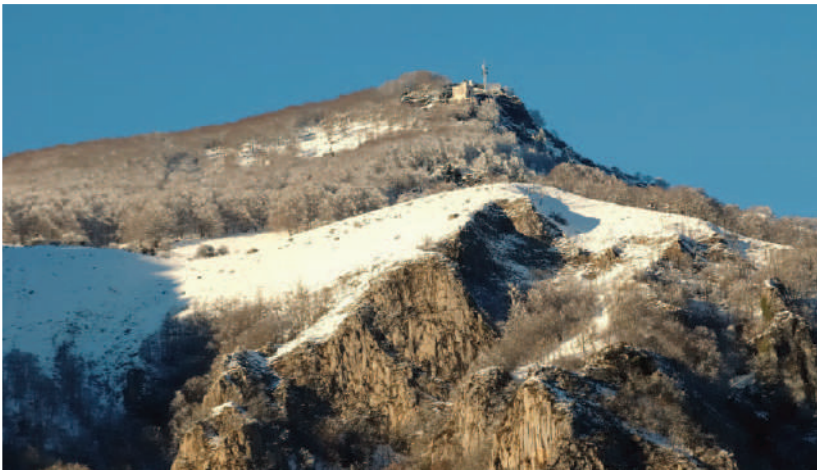
Bâtiment sommital Pibeste
